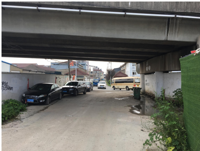
图三：桥下通道（现状净高4m）
