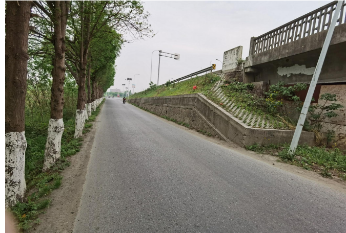
图四 练严线桥下路段
